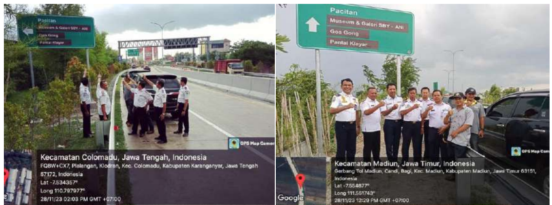
Gambar 3.1 Pembangunan Rambu RPPJ Exit Tol di Madiun Jawa Timur dan Karanganyar Jawa tengah
