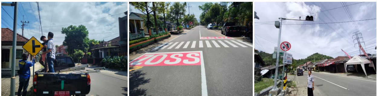
Gambar 3.2 Pemeliharaan Rambu, Warning Light dan Pemasangan Zona Selamat Sekolah
