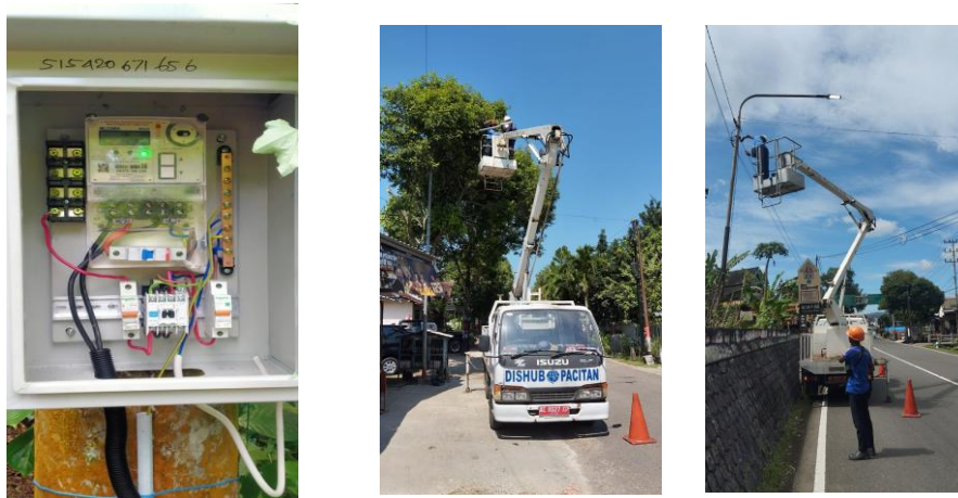
Gambar 3.3 Pemasangan Meterisasi dan Pemeliharaan PJU Kabupaten Pacitan
